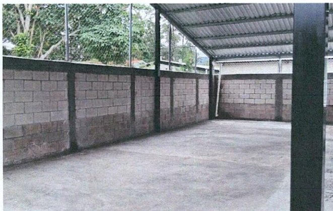
Foto 1: Área finalizada en la que se realizó el mejoramiento de los muros perimetrales mediante el levantado de block de concreto.
