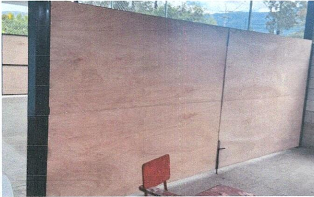
Foto 1: Área finalizada en la que se ejecutó el mejoramiento y la instalación de puertas plegables de plywood destinadas a la división del aula.
