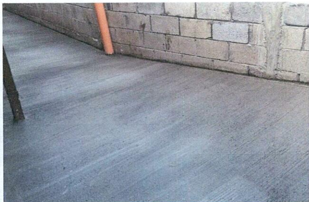
Foto 3: Área finalizada en la que se realizó el mejoramiento de la losa del patio.
